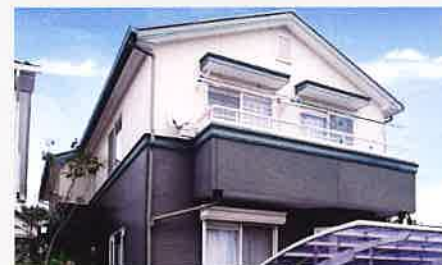
戸建て塗装工事
