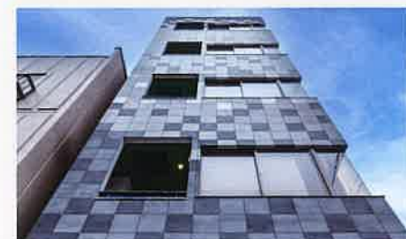
外装塗装工事(東京事務所)
